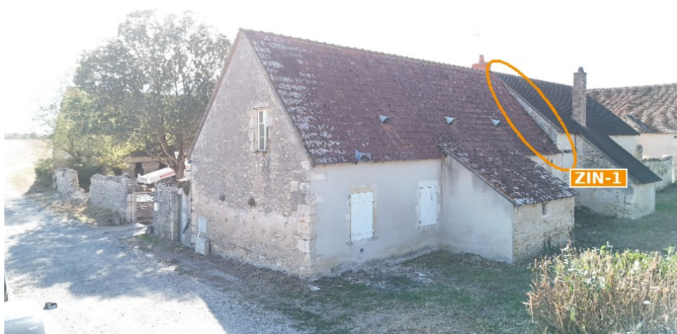
ZIN-1 — jonction pan A1 (tuile rouge) / maison B (couverture sombre, en arrière-plan).
