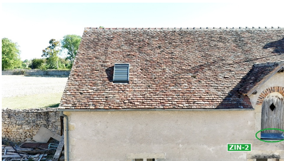
ZIN-2 — bavette d'appui de la lucarne B2_1 (en bas à droite).
