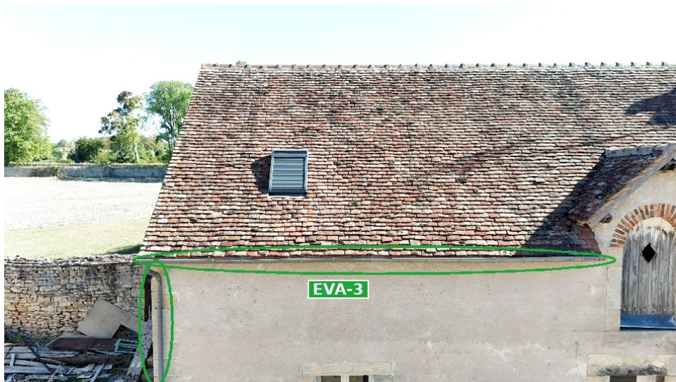
EVA-3 — gouttière du pan B2 et descente d'angle.
