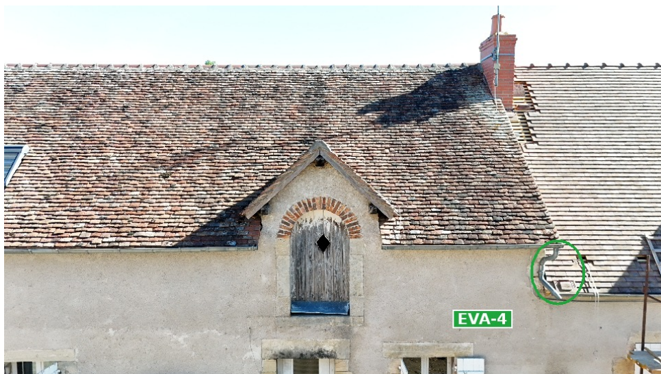
EVA-4 — descente au raccord des pans B2 et A2.
