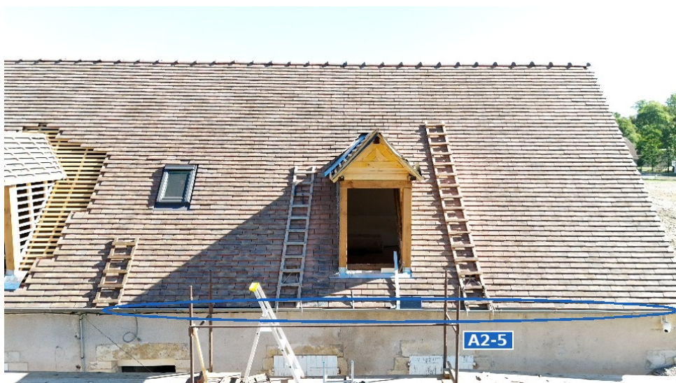
A2-5 — gouttière du pan A2 (sous l'échafaudage).
