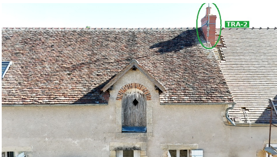
TRA-2 — souche B2_2 au faîtage, entre les pans B2 et A2.
