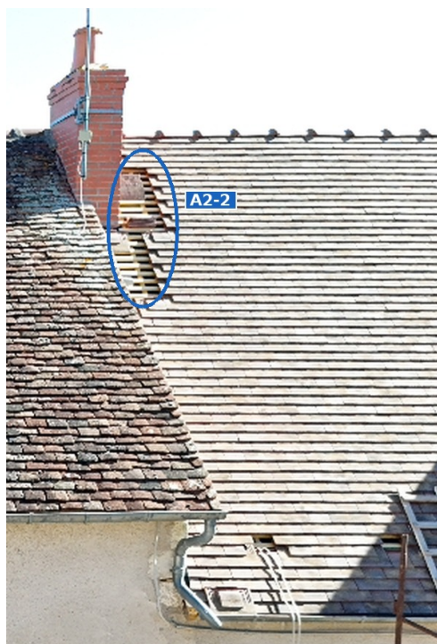
A2-2 — détail agrandi : lites entre la souche B2_2 et la tuile neuve du pan A2.
